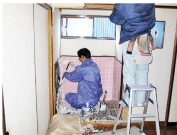
住宅改修中のトイレ（既存トイレの撤去）
